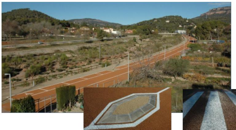
Se trabajó conjuntamente con la ingeniería y el departamento de calidad para desarrollar y adaptar el diseño de la mezcla de Hydromedia, y finalmente en el año 2021 LH entregó y colocó pavimentos de Hydromedia con el servicio de colocación y acabado (Aplytec).
