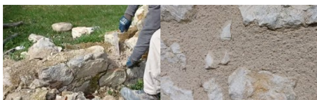
FORMACIÓN DE MUROS
